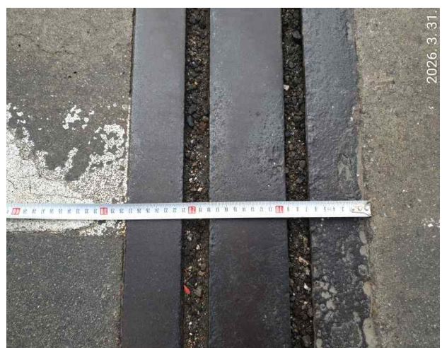
신축이음 유간 측정
